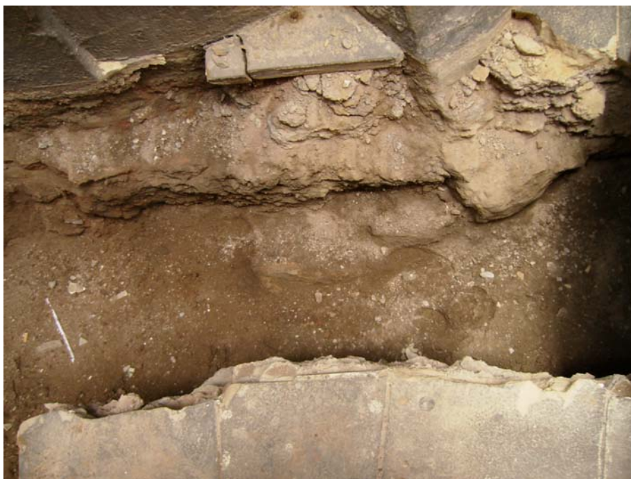
- Fotografia num. 2: detall de les fonamentacions dels edificis actuals.
