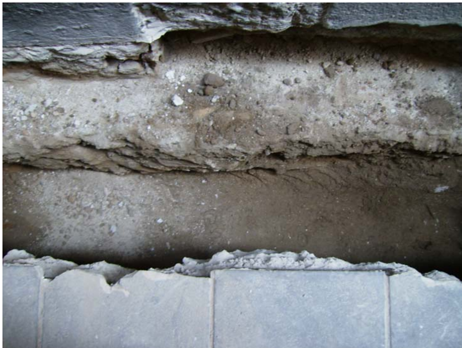
- Fotografia num.3: detall de les fonamentacions dels edificis actuals.
